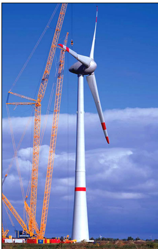
Figura 2 – Installazione presso Emden (Germania) del primo esemplare di aerogeneratore Enercon E-126, la macchina più grande sinora costruita. Potenza nominale 6 MW, diametro di rotore 126 m, altezza al mozzo 135 m, massa gravante sulla torre 550 t.
