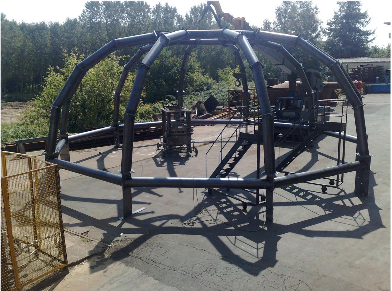
Fig. 6 – il Geode del Kite Gen in configurazione “Stem” durante la fase di costruzione dell’impianto pilota in Piemonte (Sett.2009). Il Geode è parzialmente interrato e contiene l’impianto di generazione dell’energia elettrica. Lo stelo con i cavi che pilotano il kite è montato sulla sommità del Geode. Le dimensioni reali del Geode possono essere dedotte dalle dimensioni della scala che si intravede al centro della struttura.
